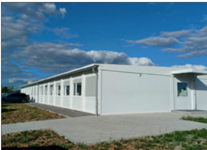
Das Bild zeigt die Gemeinschaftseinrichtung von außen, mehr Bilder auf unserer Homepage www.vgds.de in dem Bericht auf der Startseite „Einweihung Containeranlage am 20.04.2026“.
