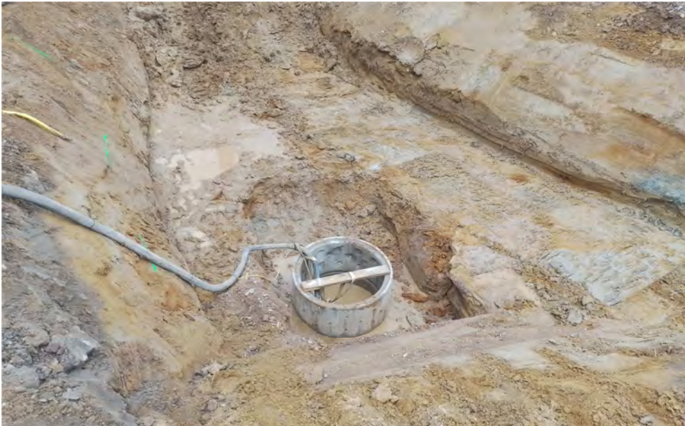
Grundwasserabsenkung im Pumpensumpf für eine grundwasserfreie Sanierungsgrube.
