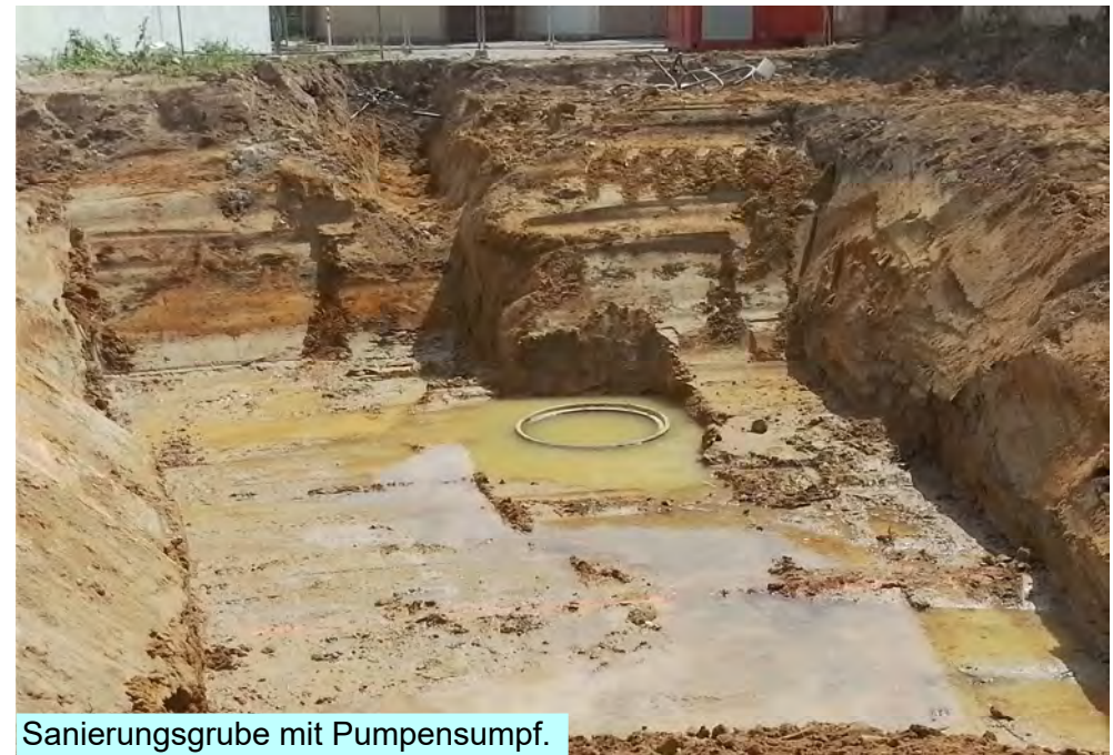
Sanierungsgrube mit Pumpensumpf zur temporären Grundwasserabsenkung.
