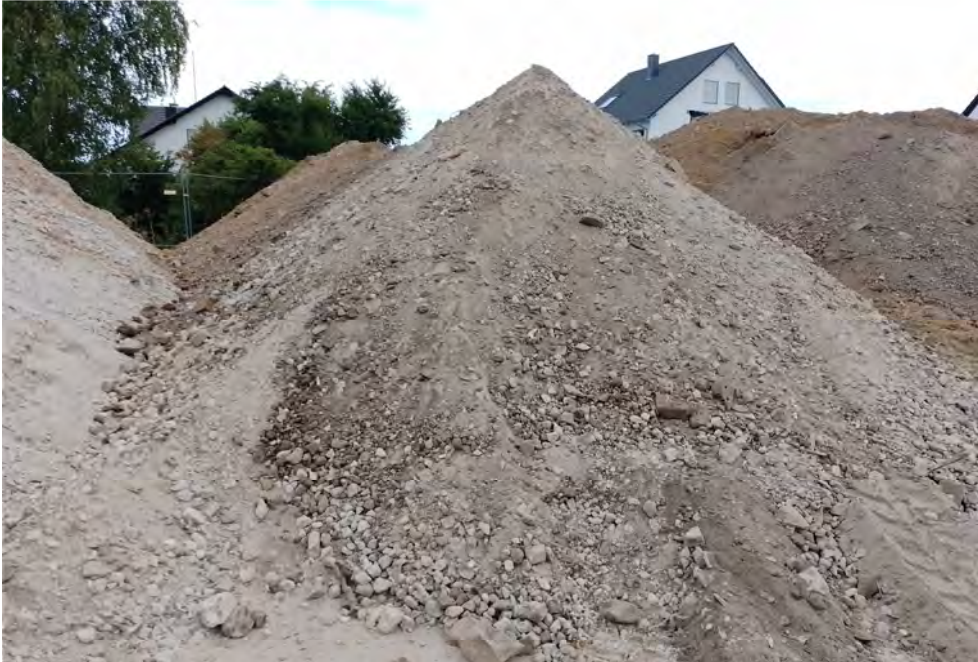
Aufgesetzte Haufwerke aus fremd- und störrstoffdurchsetzten Auffüllungen.
