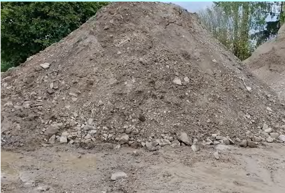
Aufgesetzte Haufwerke aus fremd- und störrstoffdurchsetzten Auffüllungen.
