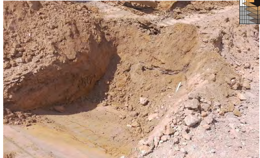
Eingrenzung des LCKW-Schadens über zahlreiche Baggerschürfe im Sanierungsbereich.
