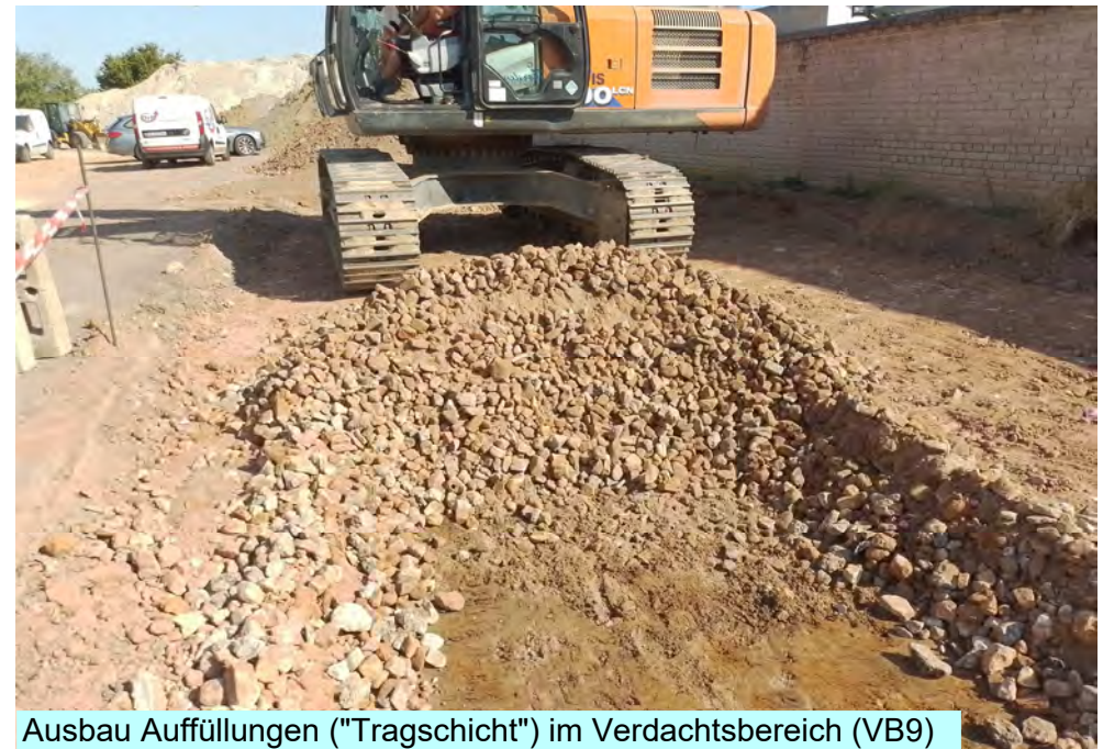
Verladung der Auffüllungen zur Entsorgung des Bodenaushubs.
