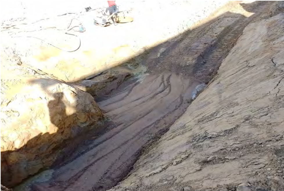
Wiederverfüllung der Sanierungsgrube im Grundwasserschwankungsbereich mit rolligem Liefermaterial (Z0 nach TR LAGA).
