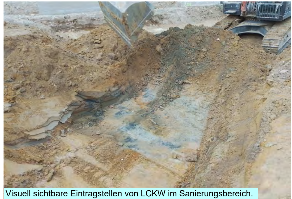
Eingrenzung des LCKW-Schadens über zahlreiche Baggerschürfe im Sanierungsbereich.
