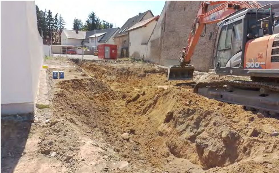
Beginn des Aushubs im LCKW-Schadensherd auf Grundlage der Erkundungsergebnisse und der begleitenden PID-Messungen.
