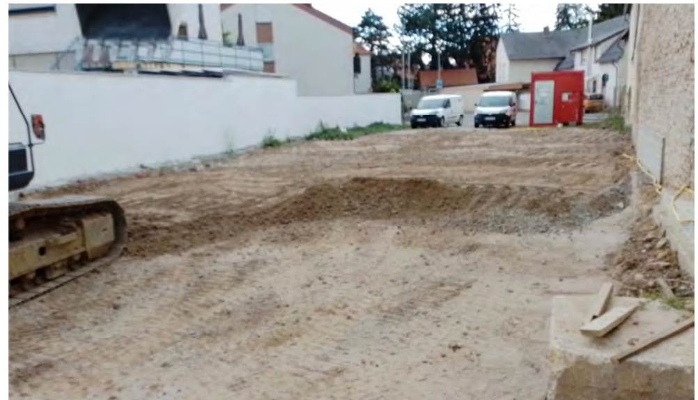
Einbau einer abschließenden Schicht aus Recycling Material im Bereich des ehemaligen LCKW-Schadensherdes, welche zukünftig als Verkehrsfläche genutzt wird.
