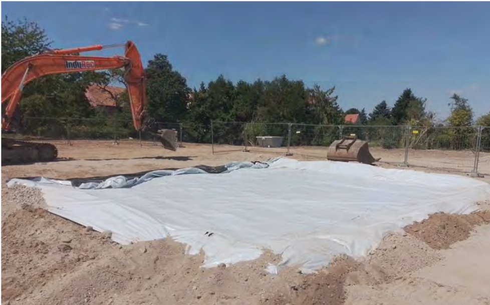
Vorbereitung Zwischenlager für LCKW-belasteten Aushub durch Folien-sicherung an der Basis.
