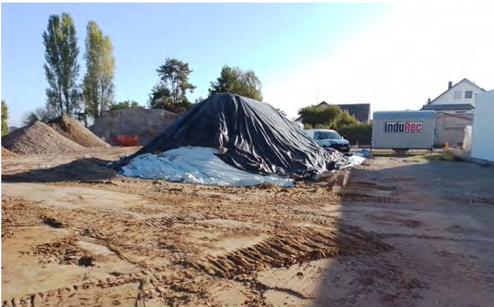
Abgedecktes Haufwerk mit LCKW-belastetem Bodenaushub aus dem Sanierungsbereich
