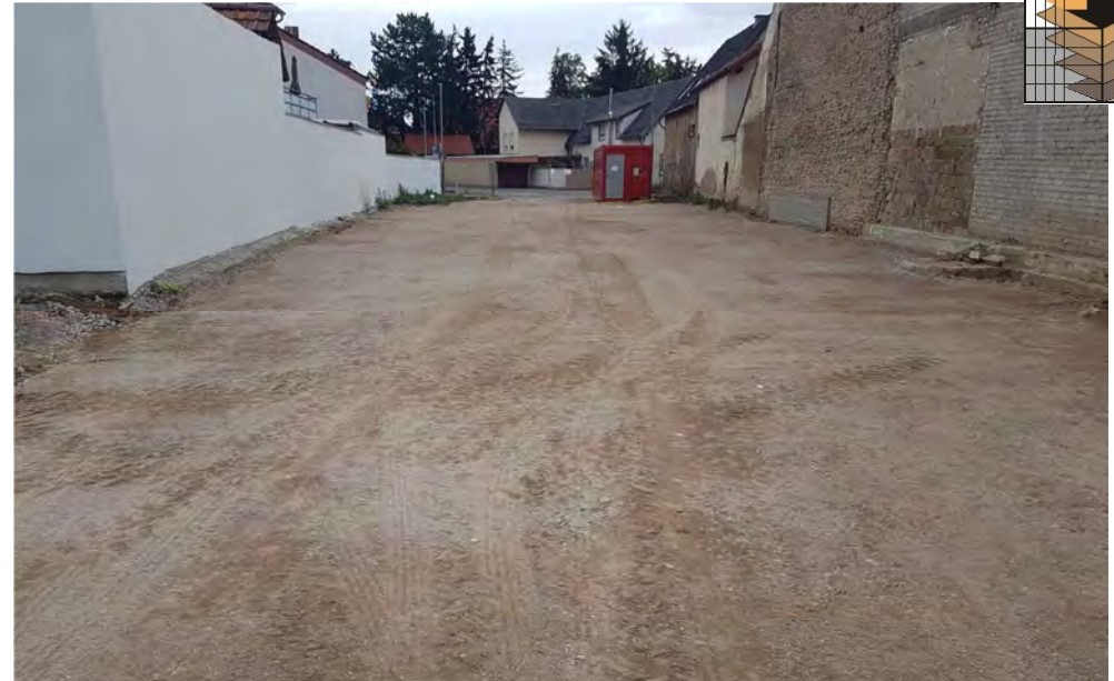
Grundwasserabsenkung im Pumpensumpf für eine grundwasserfreie Sanierungsgrube.
