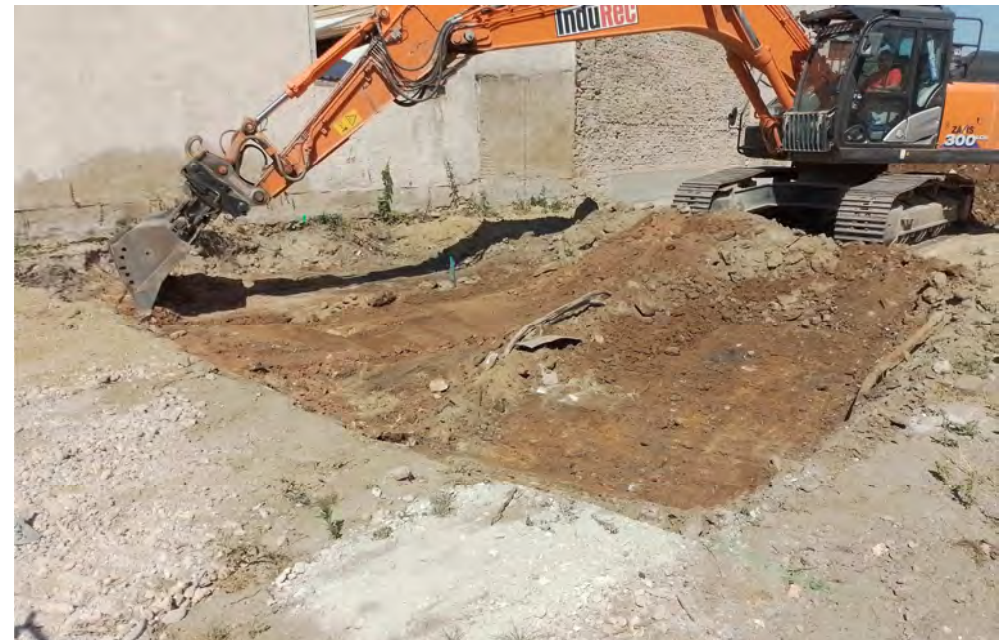
Oberflächennaher Aushub der Auffüllungen im Verdachtsbereich 7B.
