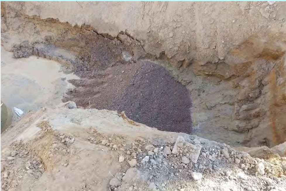
Wiederverfüllung der Sanierungsgrube im Grundwasserschwankungsbereich mit rolligem Liefermaterial (Z0 nach TR LAGA).
