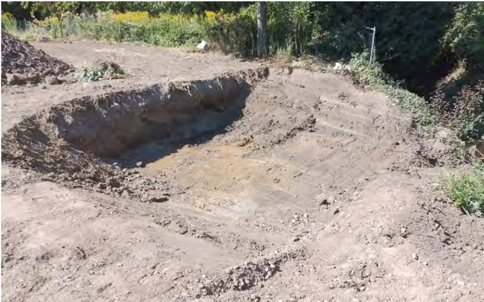
Sanierter Verdachtsbereich 5 nach Aushub der PAK-belasteten Auffüllungen.
