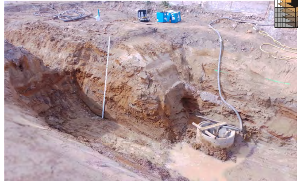
Sanierungsgrube mit Pumpensumpf zur temporären Grundwasserabsenkung.
