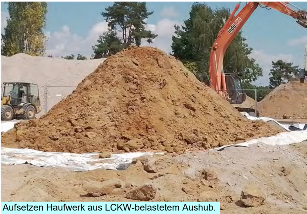
Vorbereitung Zwischenlager für LCKW-belasteten Aushub durch Folien-sicherung an der Basis.
