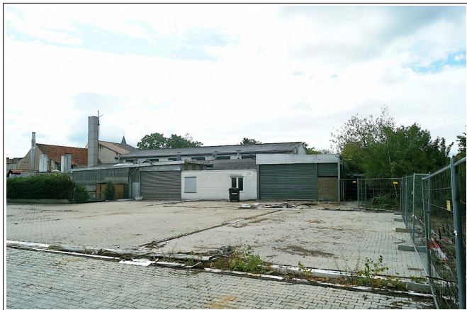
Abbildung 7: Gelände ehem. Wäscherei Hörner vor der Sanierung; Stand 2019
